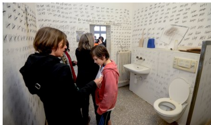
In den Gefängniszellen, hier anlässlich der letzten öffentlichen Besichtigung im März, wurde Asbest gefunden.
