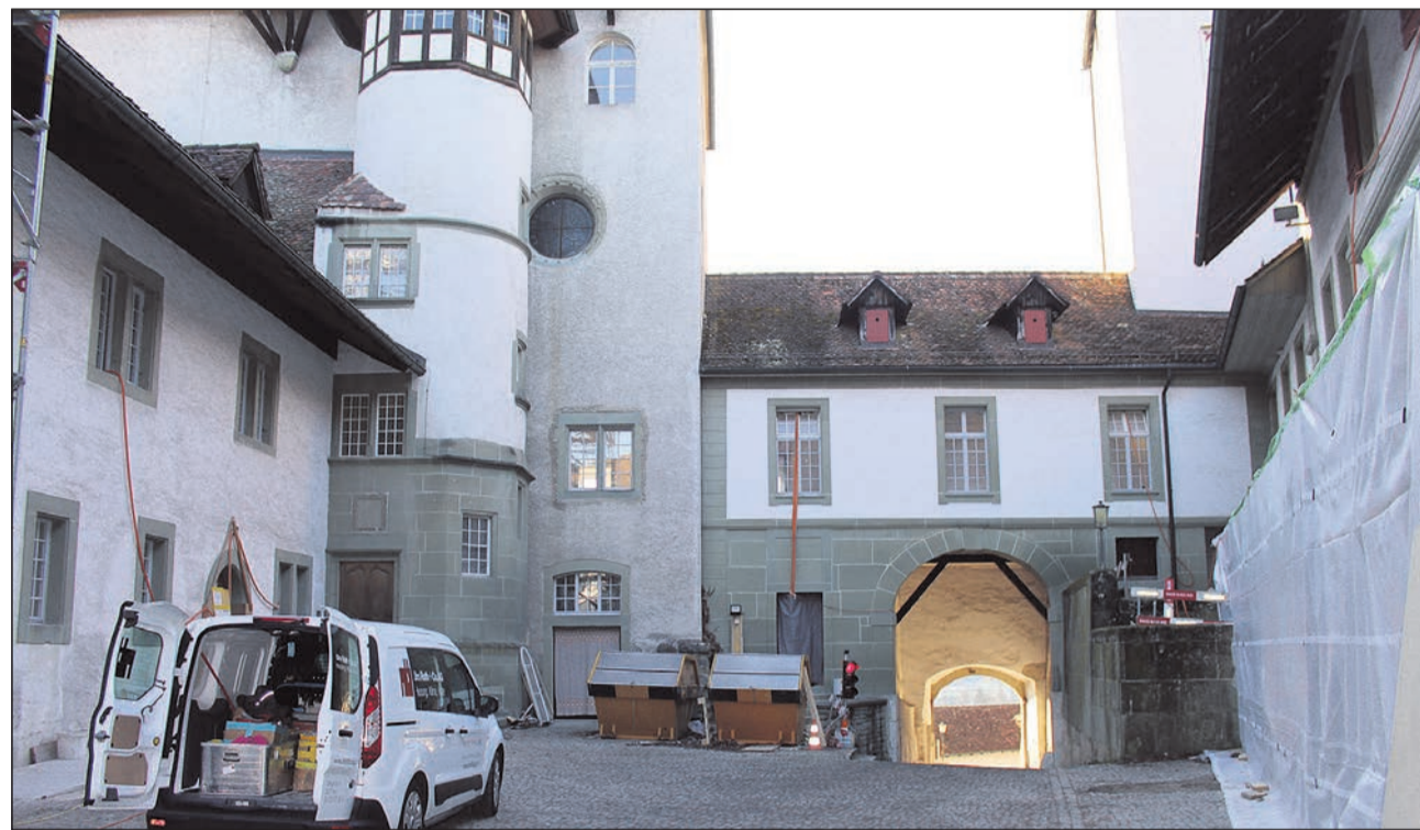
Die Umbauarbeiten sind in vollem Gange...
