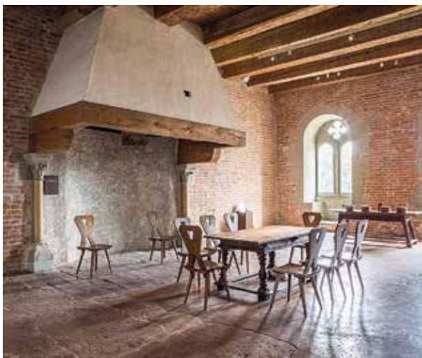
Im Rittersaal sind die seinerzeit ungewöhnlichen Materialien wie Backstein und ein früher Gussboden im Original zu erleben.
